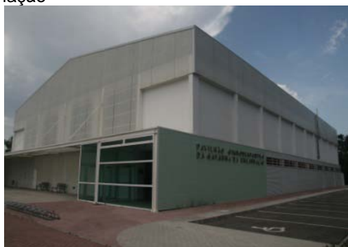
Fotografia 15. Pavilhão Desportivo da Gafanha da Encarnação
